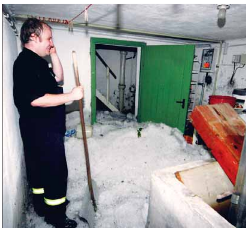
Ein Feuerwehrmann aus Durchhausen, der in der Nacht zu Donnerstag in Trossingen im Einsatz war, steht im Keller eines Wohnhauses: Der Hagel hat sich lawinenartig durch die Kellertür gefräst und dann zentimeterhoch im ganzen Keller verteilt. Die Wehr war mehrere Stunden vor Ort.
