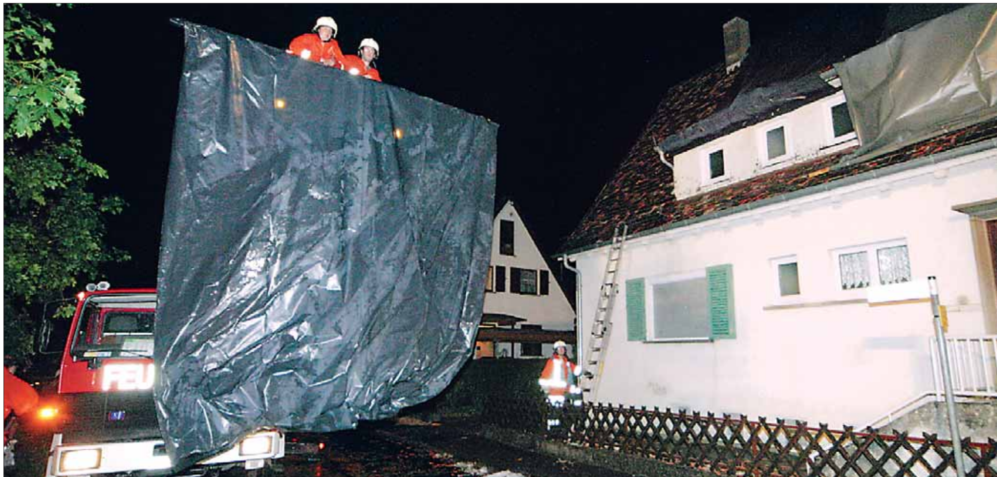
Einsatz in Trossingen: Die Spaichinger Drehleiter hat zwei Feuerwehrmänner in die Höhe gehoben. Die Männer halten eine große Plane fest, mit der sie das durch den Hagel völlig zerstörte Dach notdürftig reparieren.
