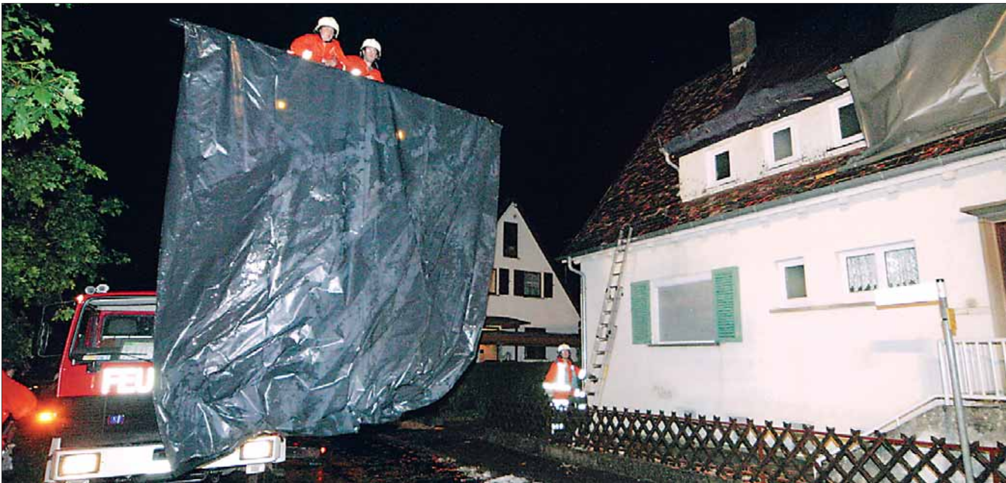
Einsatz in Trossingen: Die Spaichinger Drehleiter hat zwei Feuerwehrmänner in die Höhe gehoben. Die Männer halten eine große Plane fest, mit der sie das durch den Hagel völlig zerstörte Dach notdürftig reparieren. Fotos: Ludger Möllers
