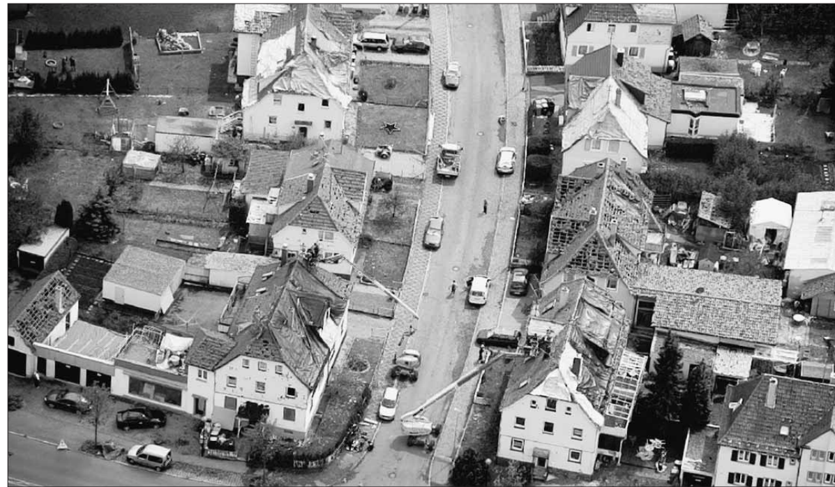
Trossingen im Frühjahr 2006 aus der Vogelperspektive: Ganze Straßenzüge, in erster Linie im Norden der Stadt, sind bei dem Hagelsturm am 28. Juni zerstört worden. Viele Bürger lebten tagelang unter lecken Dächern. Foto: Archiv
